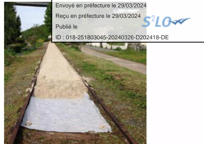
Illustration 7 Les rails et traverses ont été conservés dans le projet
